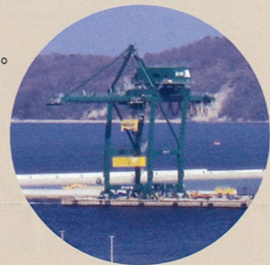
耐震強化された高松港国際物流ターミナルの岸壁とガントリークレーン
